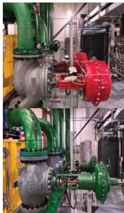
安装在发电机润滑油闭式冷却水流量控制系统中的 Fisher easy-e 阀门
